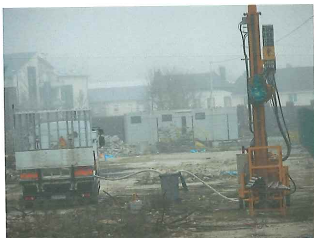
Sondage du terrain (photo prise le 14 mars 2017)
